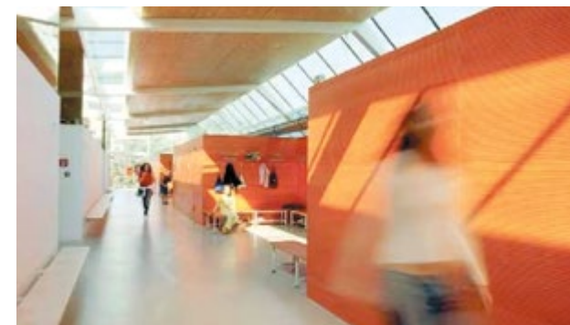
Рисунок 82 — Стеклопанели на потолке и в верхней части стен позволяют освещать коридор верхнего этажа
