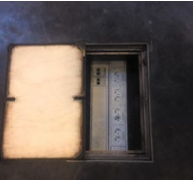
Рисунок 30 — В любом месте можно организовать учебный процесс с помощью встроенного в пол лючка с розетками для любых устройств
