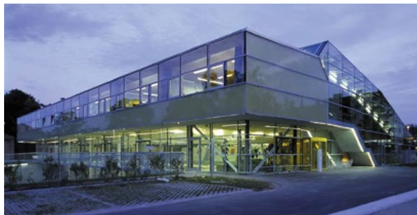
Рисунок 77 — Внешний вид школы со стороны главного входа
